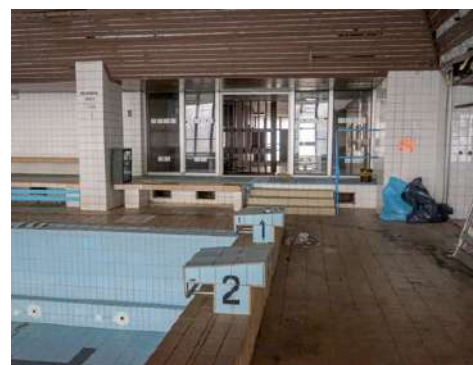
Interiér bazénu se již připravuje na stavební práce
