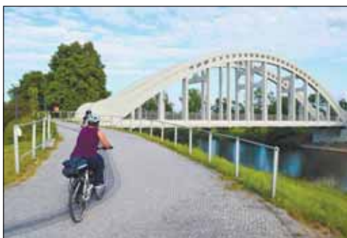
Most Sokolovských hrdinů v Karviné-Darkově má nové omítky, elektroinstalaci a v pořádku je
