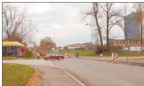
V první etapě rekonstrukce bude vybudována nová okružní křižovatka v místě stávající průsečné křižovatky ulic Havířská–Sportovní–Jaroslava Vrchlického.
