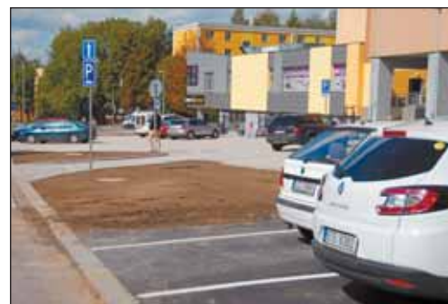
Dotace poskytnuté městu jsou vidět na každém kroku. Příkladem jsou nová parkoviště na sídlištních, které město nechalo postavit v rámci programu regenerace sídlišť.
