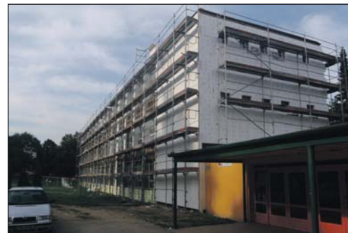
Zateplení obvodových stěn bylo provedeno v rámci letošních oprav například na Základní škole Slovenská.
