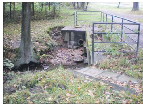
Úprava vtokové a výtokové strany poškozeného propustku č. 49/7 v lesoparku Dubina (poblíž bývalé Základní školy Žižkova) bude stát více než 1,3 milionu korun. Město počítá se zapojením státní dotace ve výši 811 tisíc korun.
