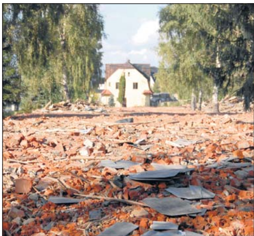
V lokalitě Vagonka by v budoucnu měla vzniknout průmyslová zóna, ve které naleznou pracovní příležitost stovky lidí.
