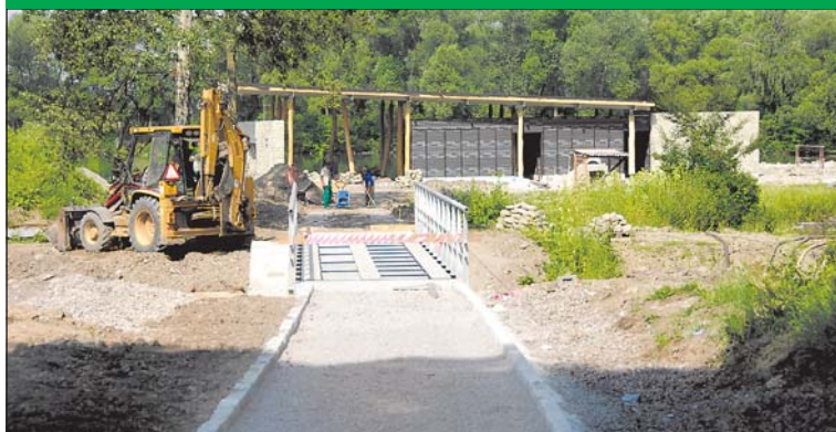
Od jara letošního roku probíhá v parku Boženy Němcové v Karviné-Fryštátě výstavba nového areálu loděnice, který bude stát na uměle vytvořeném ostrůvku. Do výstavby areálu, která by měla skončit ještě v letošním roce, investuje město desítky milionů korun. (NK)
