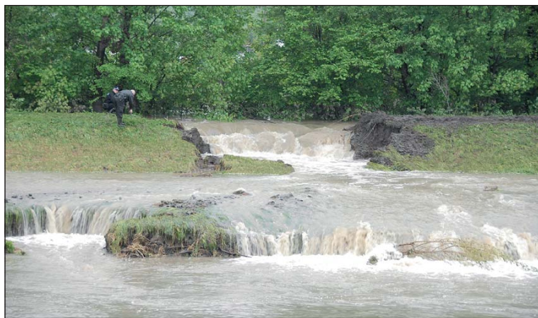
Aby se usnadnilo odtékání vody ze zatopené části Darkova, je ve čtvrtek 20. května v odpoledních hodinách provedeno prokopání levé hráze řeky Olše.
