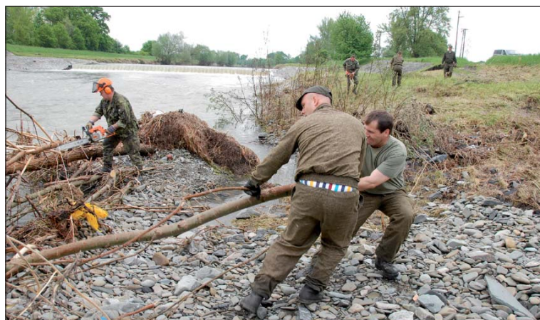
V sobotu 22. května dorazilo do Karvině vojsko. Stočlenná jednotka z vojenského útvaru v Práslavicích byla během následujících dnů nasazena na čištění koryta řeky Olše a likvidaci následků povodně v Karvině a okolí.
