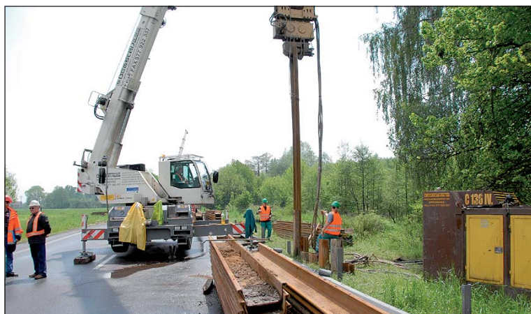
V pátek 21. května začaly intenzivní opravy poškozeného neprůjezdného úseku důležité komunikace v Loukách spojující Karvinou s Českým Těšínem.
