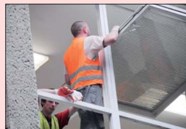
Výměnu oken chtějí na Základní škole Mendelova stihnout do začátku nového školního roku.
