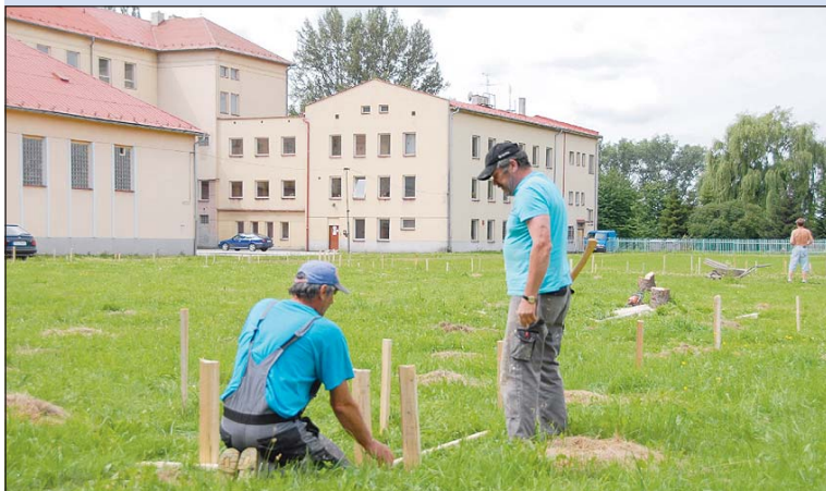
Na travnaté ploše u Základní školy Družby už brzy vzniknou nové volejbalové kurty s kompletním zázemím.
