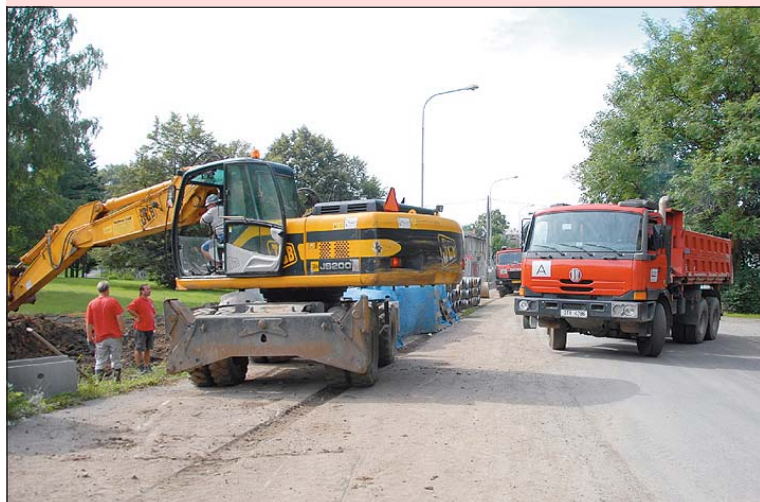
Výstavba nové kanalizační sítě probíhá na deseti místech ve městě. Na snímku: pokládání kanalizačního potrubí v Karviné-Darkově.
