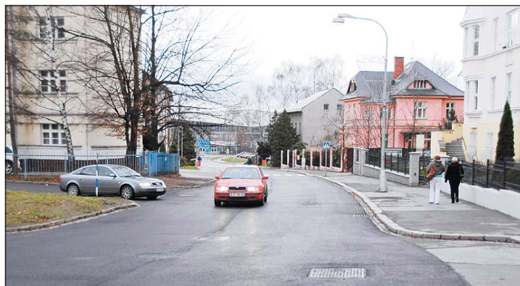
Ulice K. Sliwky je opět průjezdná. Od 20. listopadu je opět průjezdná ulice Karola Sliwky v centru města v Karviné-Fryštátě. Po dobu dvou měsíců – od poloviny září – tu byly prováděny opravy kanalizační sítě, a to v úseku od křižovatky s ulicí Mlýnská až po Komerční banku. Po dokončení oprav byl po celé délce opravovaného úseku vozovky položen nový, asfaltový povrch.
