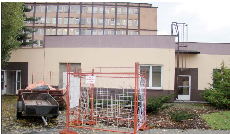
Dostavba centrálního příjmu NsP v Karviné-Ráji běží na plné obrátky.
