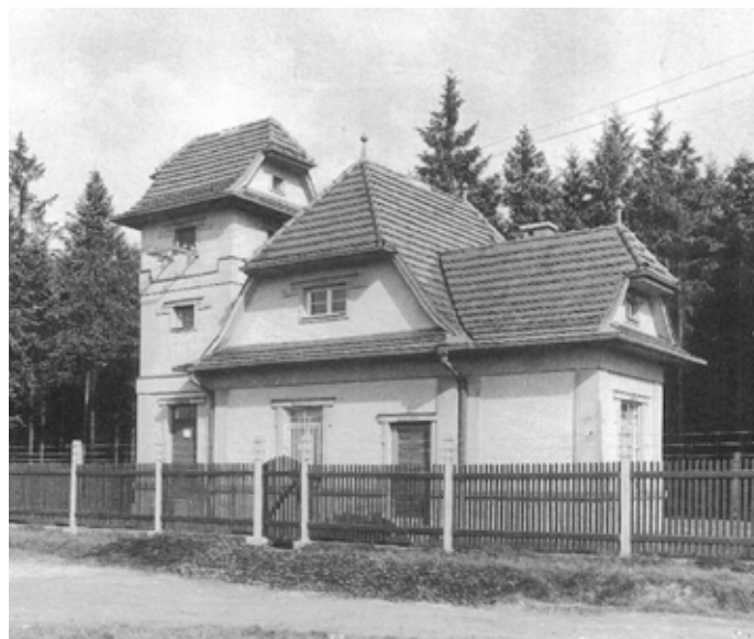
Čerpací stanice č. 2 u konečné tramvají v Bělském lese, stav po dokončení; okolo 1934
