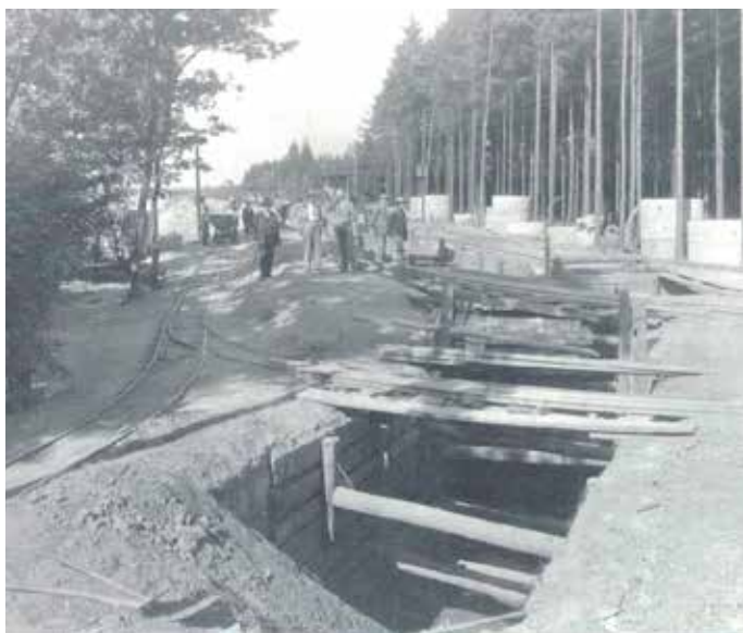
Stavba podzemní štoly propojující studny I. řádu u dnešní Kolibý; 1932
