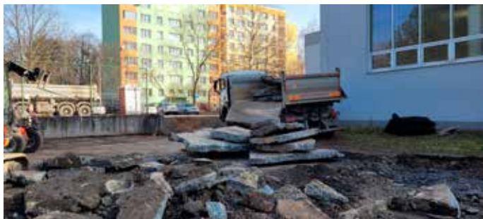
Práce na multifunkčním Hřišti za školou byly zahájeny.
