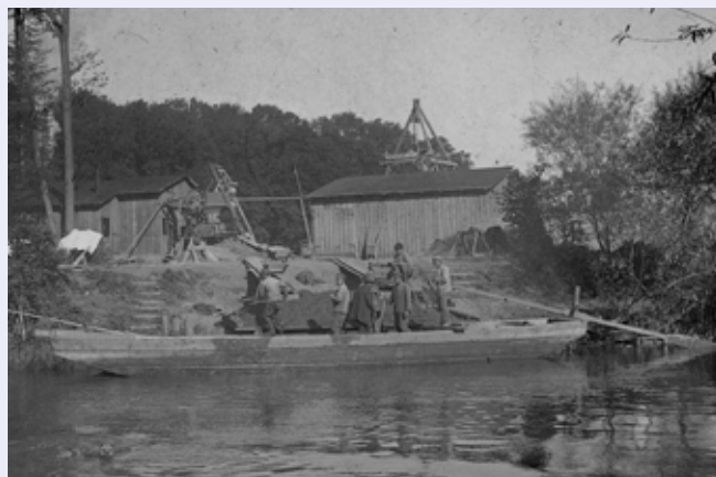
Unikátní pohled na stavbu mostu přes Odru v roce 1916.
