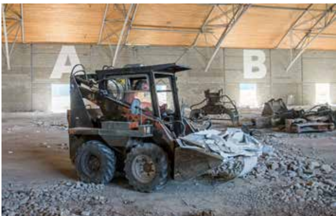
Ve sportovní hale se intenzivně pracuje.
