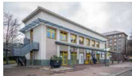
Budova G-CENTRA, kde se budují zubní ordinace.
