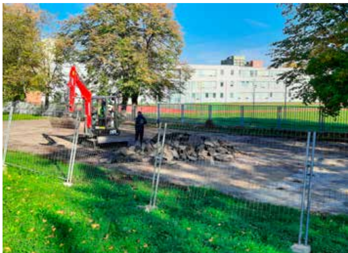
Průběh stavby na Indiánském hřišti na Dubině. Práce budou pokračovat na jaře. (Zdroj: ÚMOB Jih)
