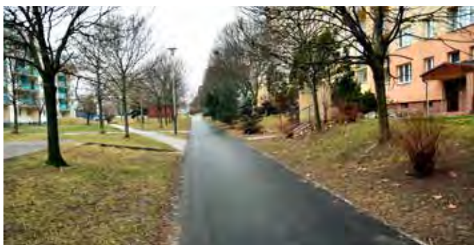
V loňském roce byl mimo jiné opraven chodník na ulici Ladislava Hosáka.
