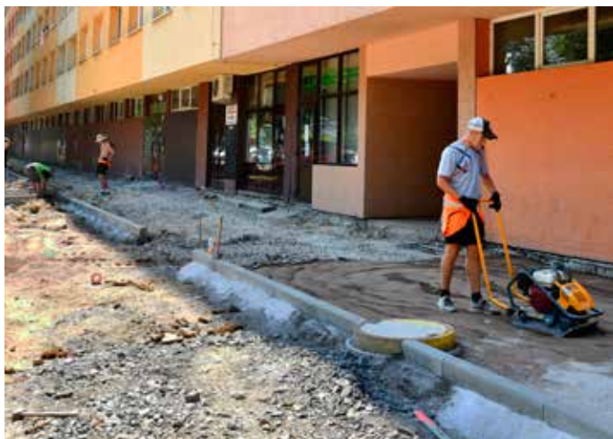
Na ulici Františka Hajdy se pořád pracuje...
