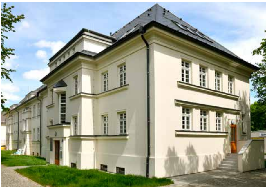
Opravený dům na ulici Velflíkova 14
