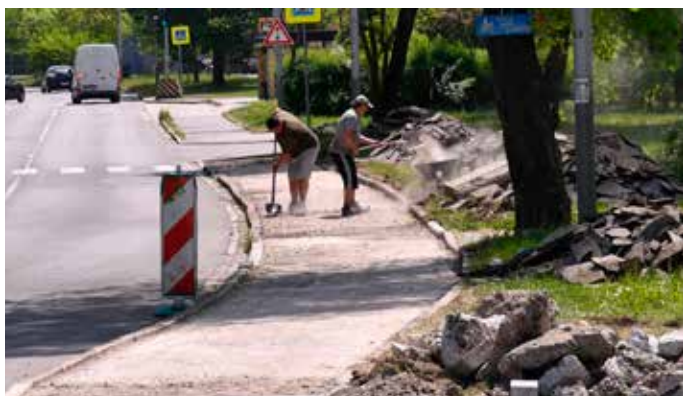
Jedním z míst, kde se v současnosti opravují chodníky, je také ulice U Hrůbků.
