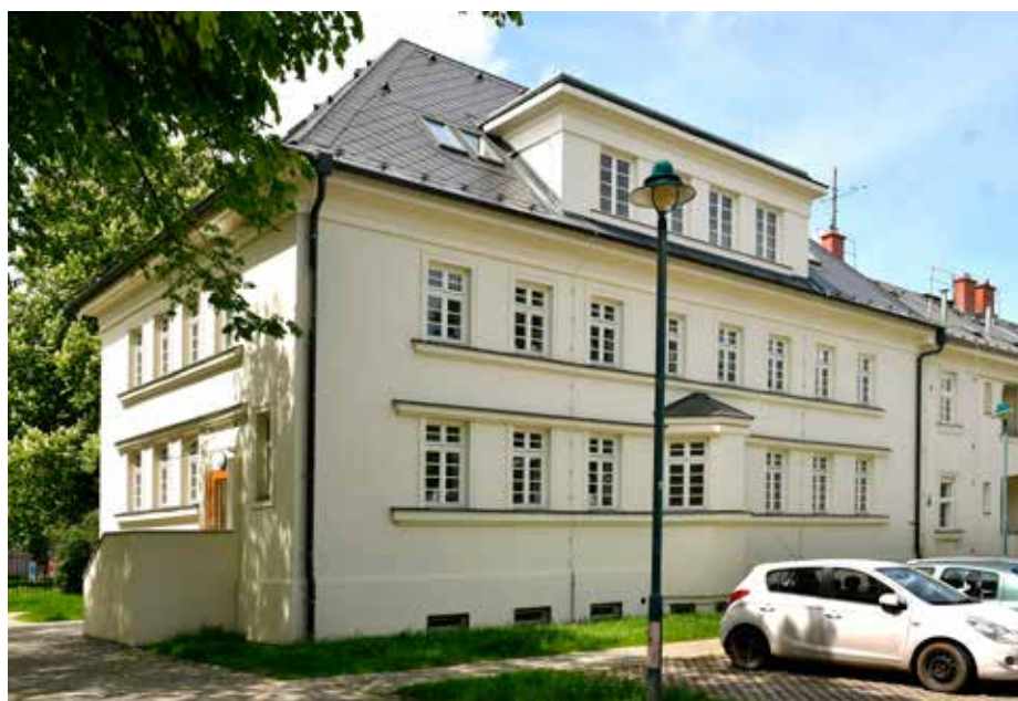
Jednou z významných investičních akcí v bytové oblasti byla rekonstrukce objektu na ulici Velflíkova v Jubilejní kolonii.
