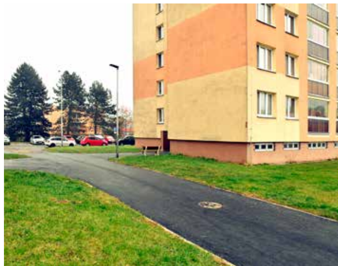
V Zábřehu prošel rekonstrukcí chodník na ulici Zimmerlova.
