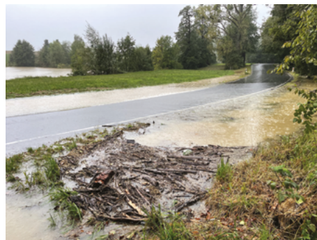
Ucpáný propustek a voda od Klimkovic
