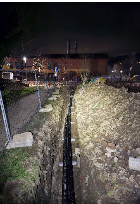
Obnažený výkop nového teplovodu TUV
