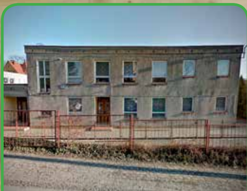
Mateřská škola před rekonstrukcí
