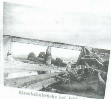
Eisenbahnbrücke bei Jablunkau.
