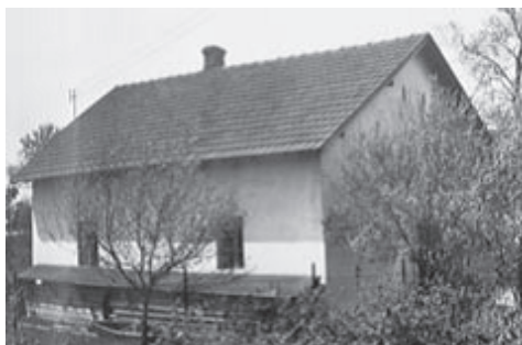
Dům čp. 38 – budova MNV postavená v roce 1928.
