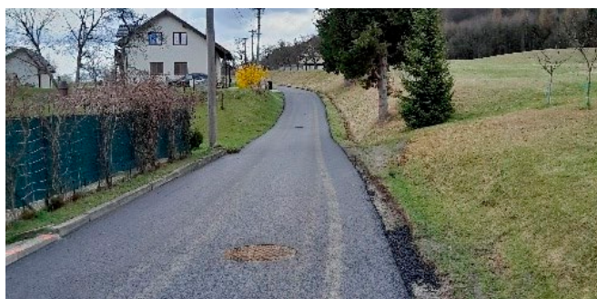
Nový asfaltový povrch MK na kanalizační stoce.
