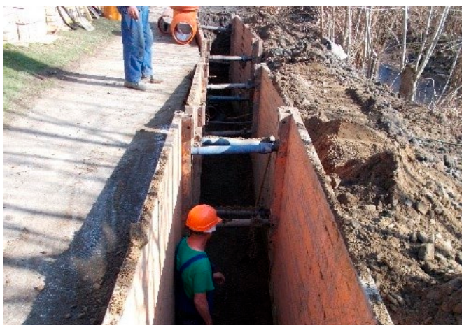
Přípravu pro pokládku kanalizační stoky.
