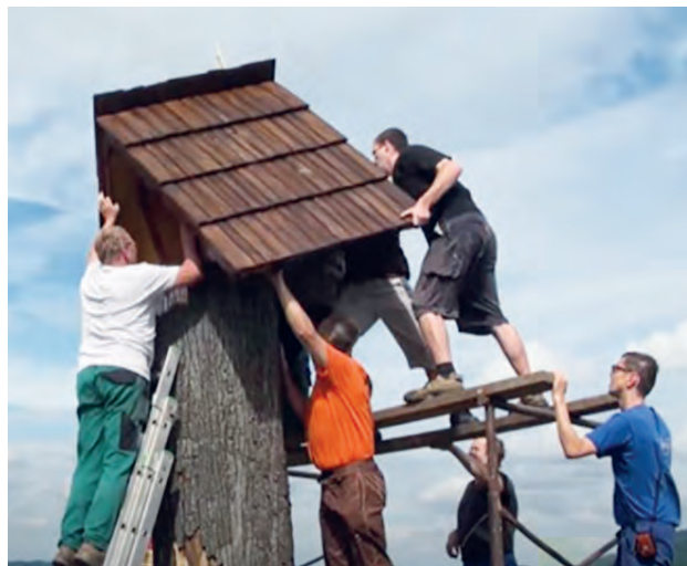
Instalace zvoničky na své místo. – A je to!
