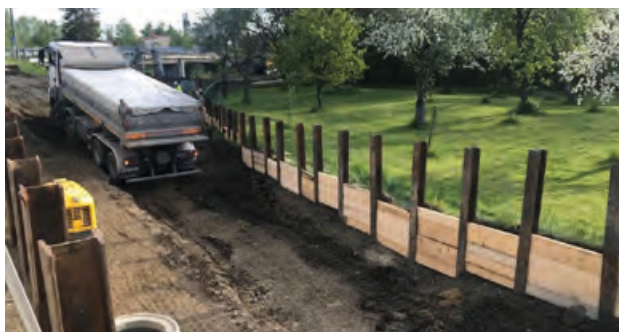
Stavba silnice a mostu na Dolním Sklenově
