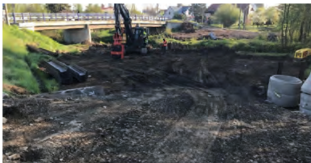
Rekonstrukce mostu na Dolním Sklenově, foto: stavební dozor
