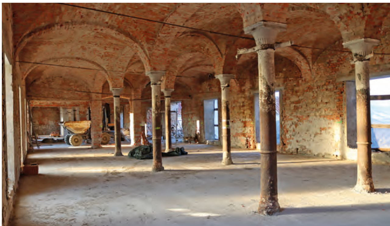
Rekonstrukce kravína v hukvaldském dvoře, stav z února 2022. Foto: Miroslav Bitter
