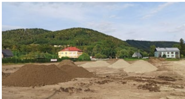
Návoz materiálu na celoplošnou drenáž
