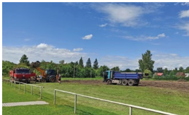
Skrývka původního povrchu – využití místní firmy pana Opěly
