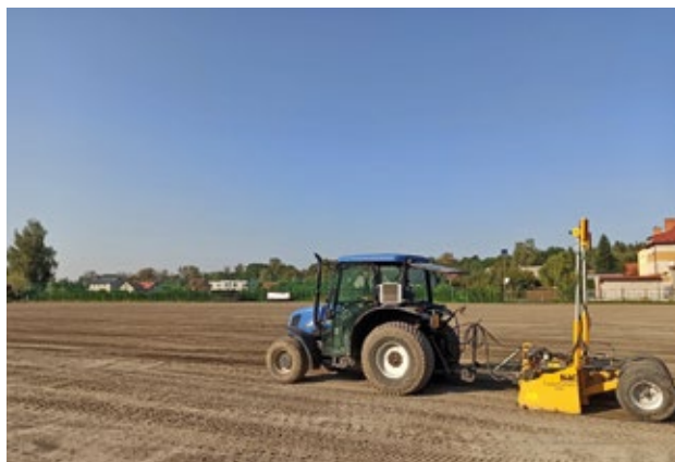
Závěrečné srovnání plochy laserem naváděným graderem
