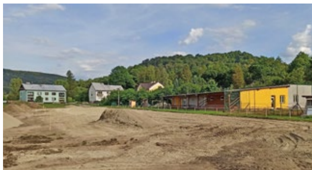
Návoz materiálu na celoplošnou drenáž
