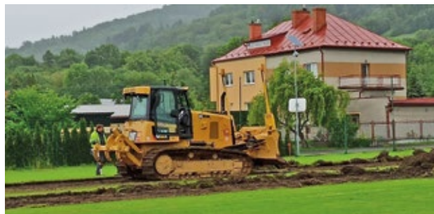
Skrývka původního povrchu – laserem naváděný buldozer
