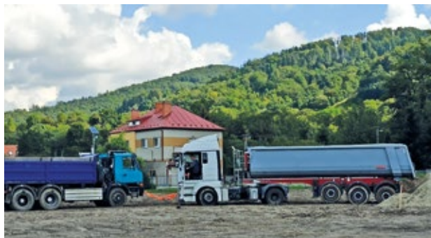
Dovoz křemičitého písku a opět p. Opěla v akci, když tahal zapadlý tahač
