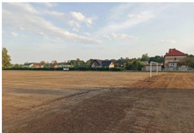
Hotovo – smíchán písek s hlínou, srovnáno, zaválcováno
