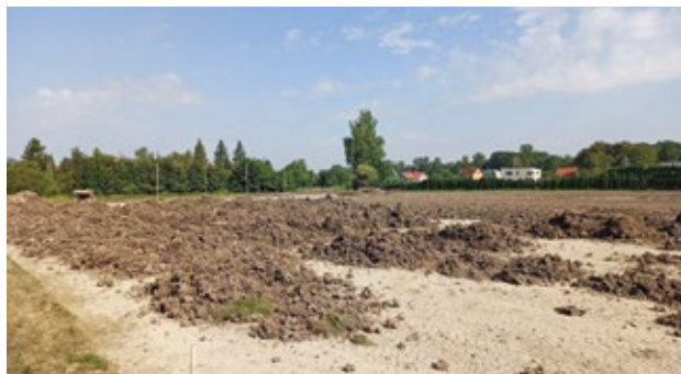
Rozvoz původní zeminy na celoplošnou drenáž
