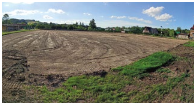
Skrývka původního povrchu – hotovo, včetně zmírnění původních výškových rozdílů
