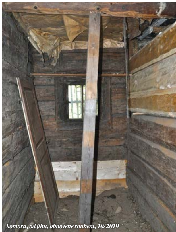
Světnička (kuchyně), pohled od jihu, obnovené roubení, 10/2019
