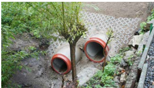
Zpevnění mostku v Horním Sklenově
