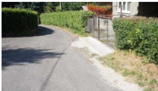
Odvodnění cesty na chatovišti
