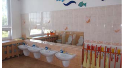
Rekonstrukce sociálního zařízení v MŠ
