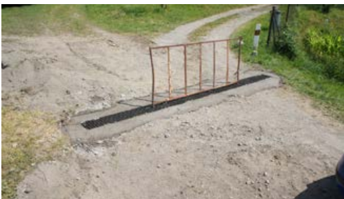
Odvodnění komunikace v Dolním Sklenově
