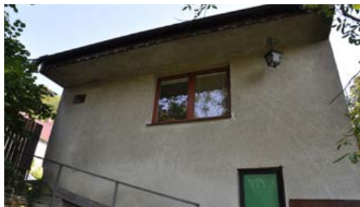
Výměna oken - hasičárna Hukvaldy
