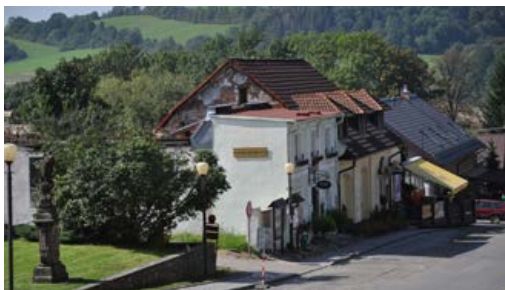
Vybourání štítu a oprava střechy
