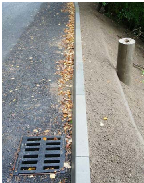
Zpevnění břehu na chatovišti
