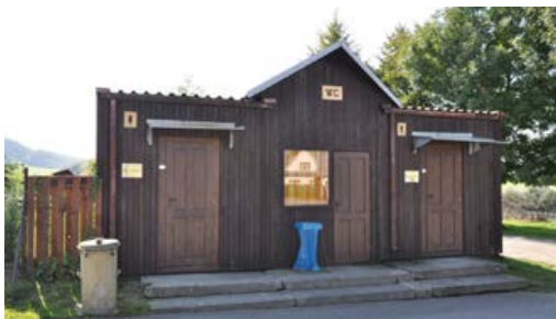
Oprava dveří WC na parkovišti
