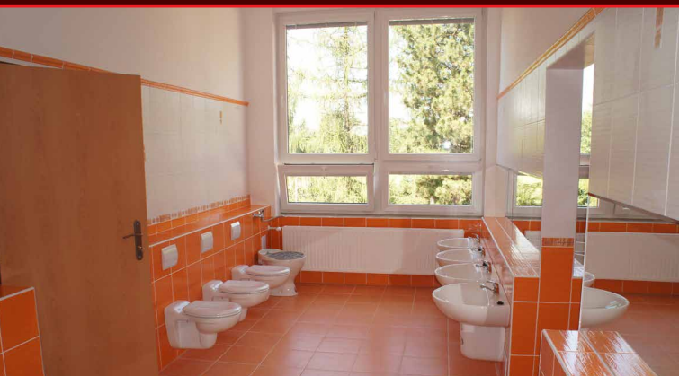
Rekonstrukce sociálního zařízení v MŠ
