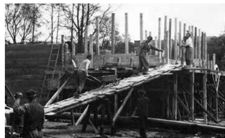
Stavba čističky vody s venkovními sprchami (foto z 14. 5. 1956)
