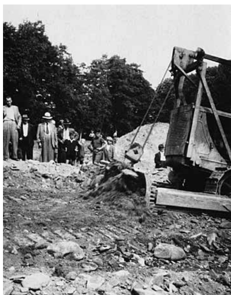
Zahájení výstavby koupaliště – příjezd buldozeru za přihlížení diváků (1952)
