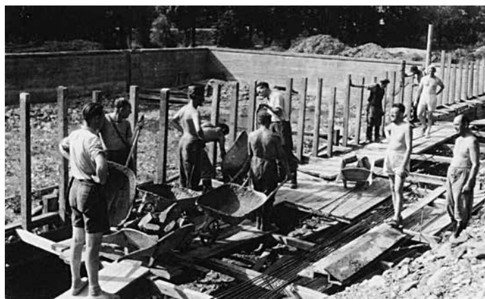
Betonování západní stěny (v trenýrkách Alois Bílík, za ním František Beinhauer)
