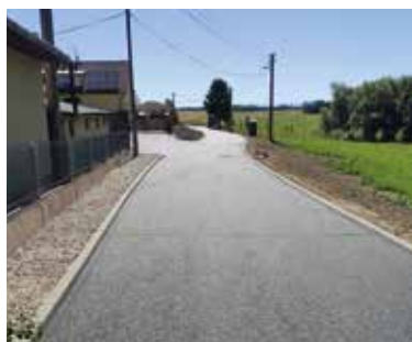
Opravena byla vozovka a kanalizace v Jakubčovicích.
