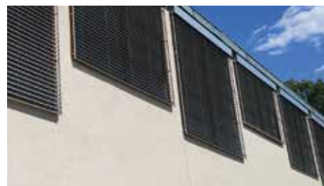
V srpnu byla instalována nová stínící technika na sportovní halu základní školy v Hradci.
