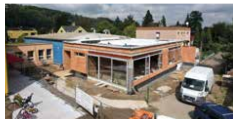
V květnu začaly stavební práce na přístavbě mateřské školy v Hradci.
