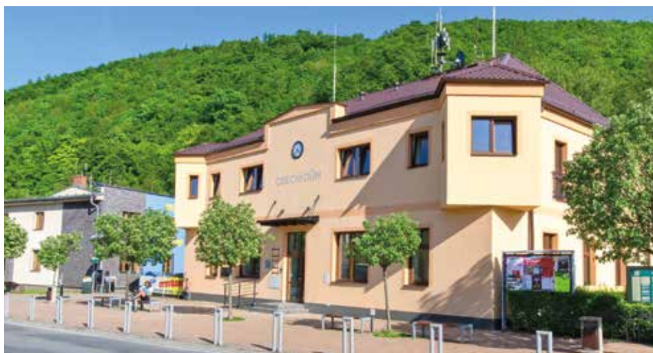
Pokládkou parket v sále byla v červenci završena rekonstrukce Obecního domu v Žimrovicích.
