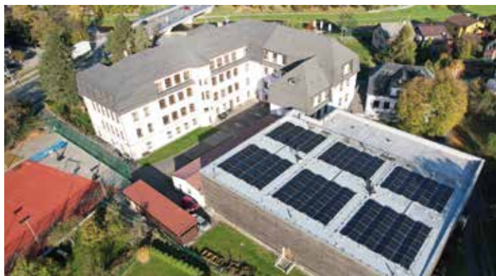
V únoru byla na střeše sportovní haly základní školy v Hradci dokončena instalace fotovoltaické elektrárny o výkonu 99,36 kWp, jejíž součástí je bateriové úložiště.
