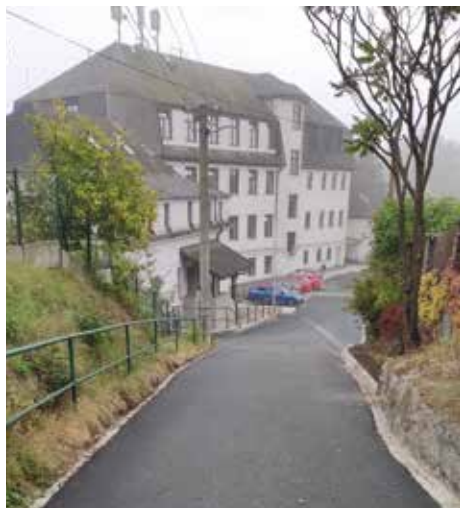
Během letních prázdnin proběhla rekonstrukce ulic Husova a části ulice Na Cihelně.
