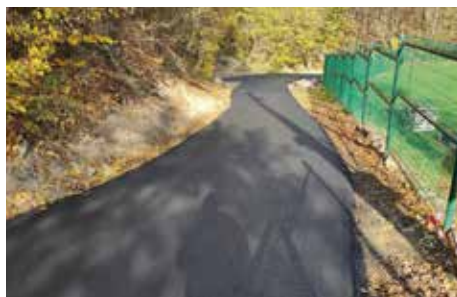
Od začátku listopadu mohou občané i návštěvníci Domoradovic využívat nově zrekonstruovanou komunikaci k místnímu hřišti.
