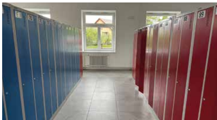
Během letních prázdnin byla provedena výměna podlahy v šatnách hradecké základní školy.
