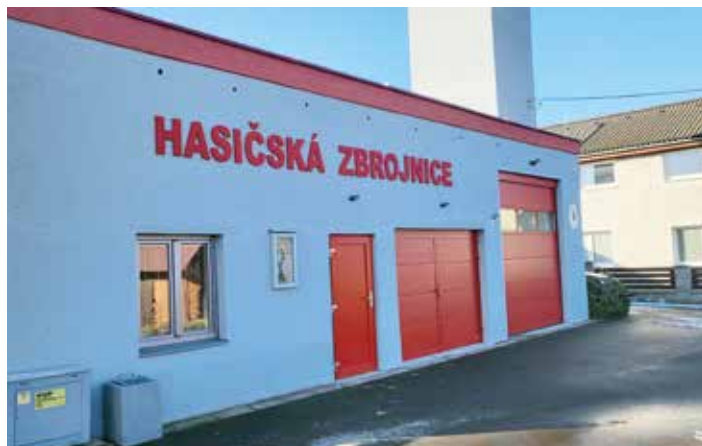
Poslední srpnovou sobotu proběhlo slavnostní otevření zrekonstruované hasičské zbrojnice v Domoradovicích.
