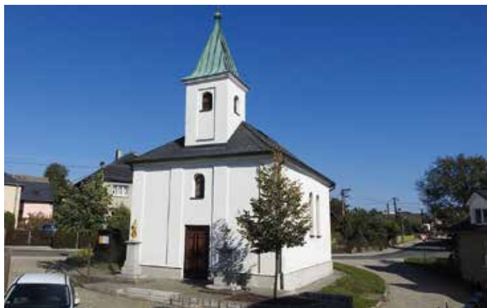
Na začátku srpna byly dokončeny stavební práce na opravě kaple Navštívení Panny Marie v Jakubčovicích.
