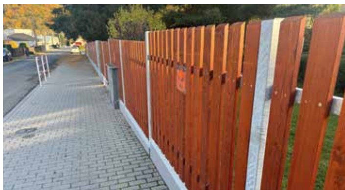
Na podzim bylo opraveno oplocení základní školy v Žimrovicích.
