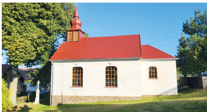
Na podzim byly natřeny střechy kaplí v Benkovicích a Filipovicích.
