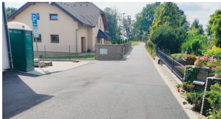
Na konci června byla dokončena rekonstrukce nebezpečné komunikace u hasičské zbrojnice v Jakubčovicích.
