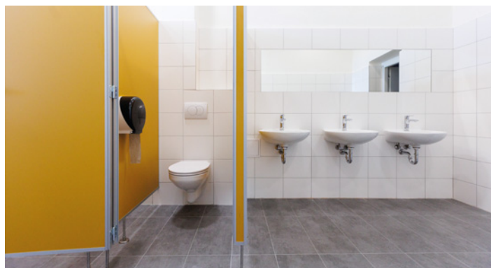
Na začátku školního roku obdržela hradecká základní škola dárek v podobě kompletně zrekonstruovaných sociálních zařízení.
