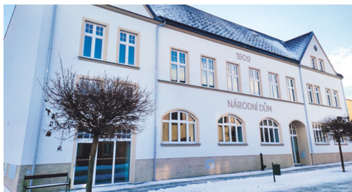
V prosinci byla dokončena stavební část celkové rekonstrukce budovy Národního domu.
