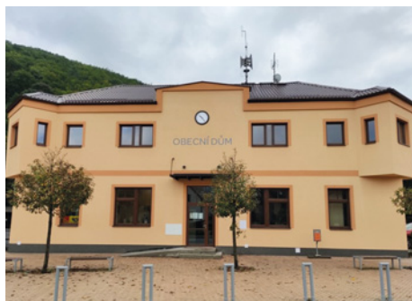
5 Opravený Obecní dům
