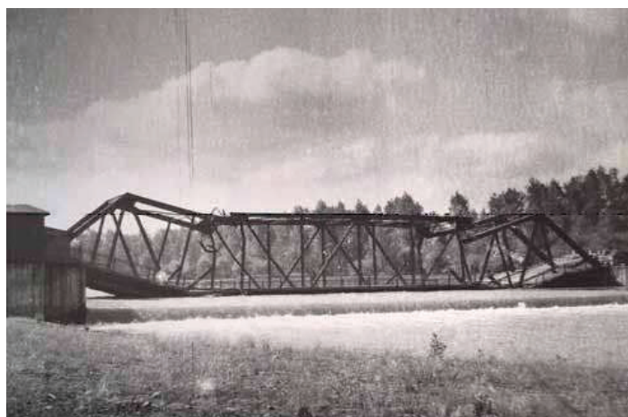
Vratimovský most, který výbuchem 1. května 1945 poškodila ustupující německá vojska (Archiv města Ostravy)
