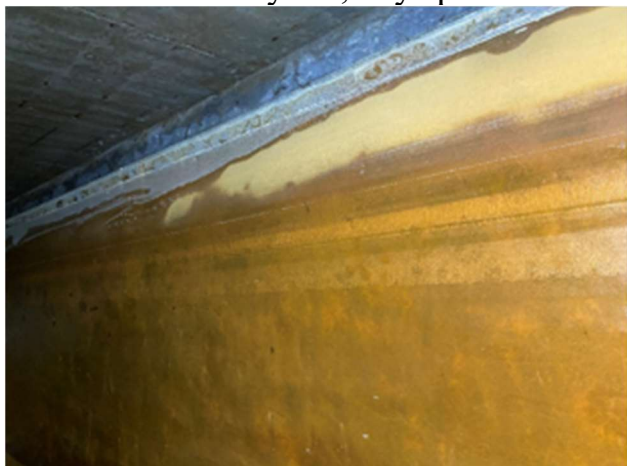
Stěna komory vodojemu před čištěním
