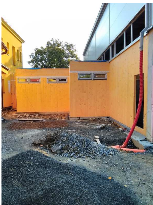
Pohled na dřevěnou přístavbu sociálního zázemí ze zahrady za mateřskou školou.
