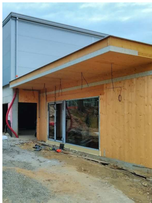
Budoucí vstup do tělocvičny
