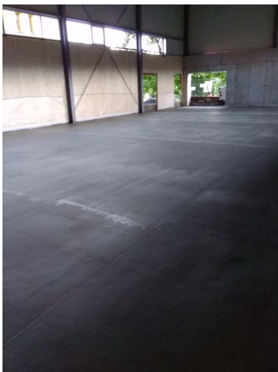
Foto vnitřního prostoru tělocvičny, ukazující její rozlohu
