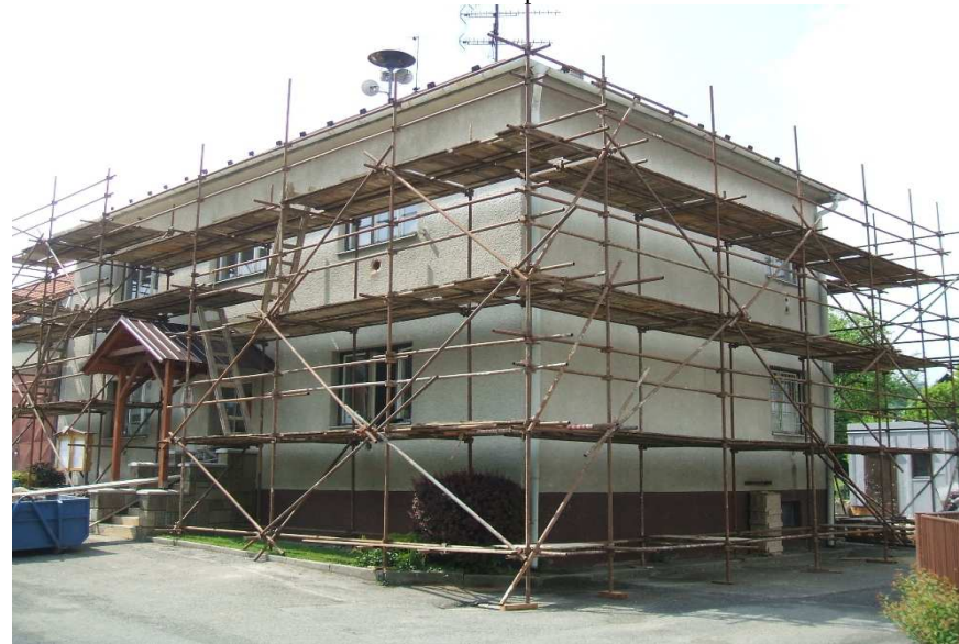
Zateplení podlahy v kancelářích
