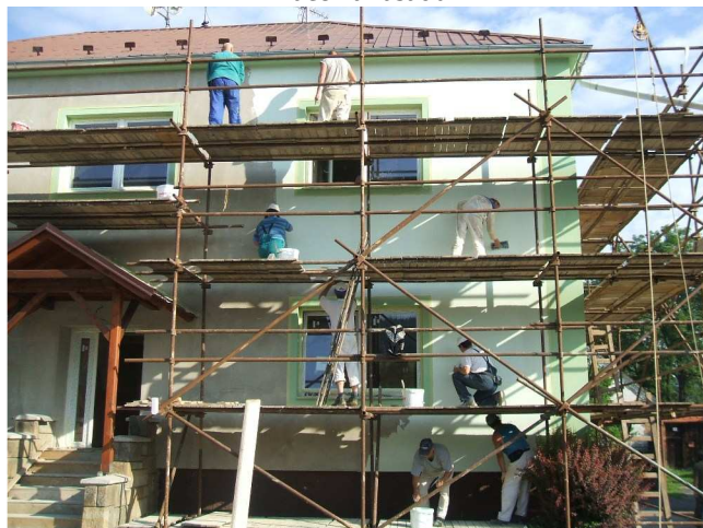
Práce na fasádě
