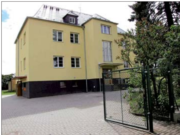
Budova bývalého dětského domova po rekonstrukci, foto: (R.G.)
