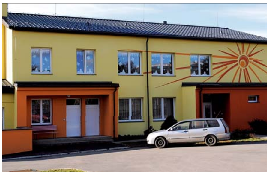
Nově opravená budova mateřské školy v H. Benešově, foto: Město H. Benešov
