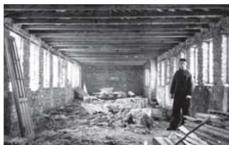
výstavba kuželny u bývalého nádraží v Horním Benešově
