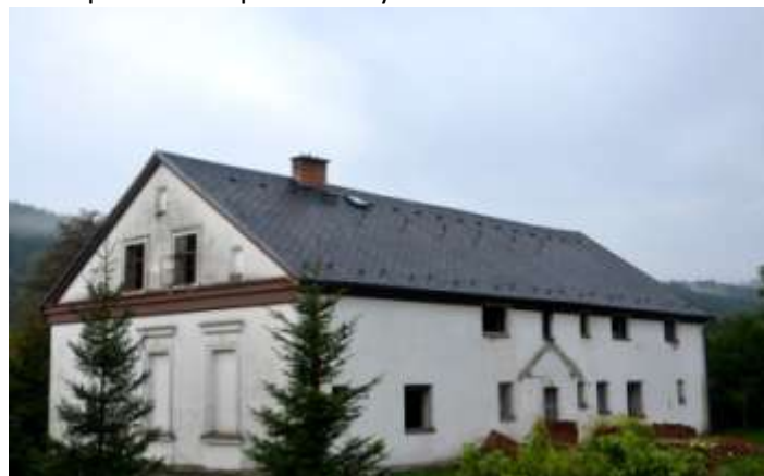
Foto: bytový dům v Hejnově s novou střechou
