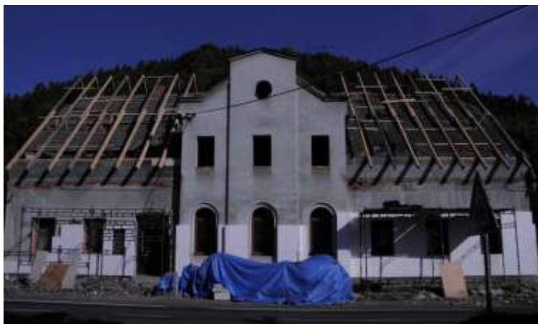
Foto: v centru obce vzniká dům pro seniory a zdravotně postižené
