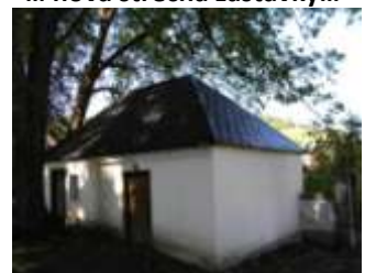
... nová střecha márnice...
