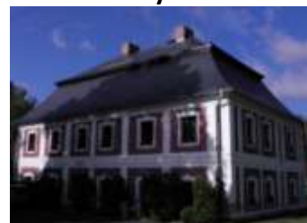
... nová střecha OÚ...
