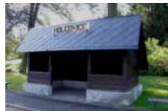
... nová střecha zastávky...
