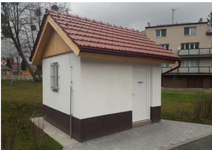
Tlaková stanice k vodovodu
