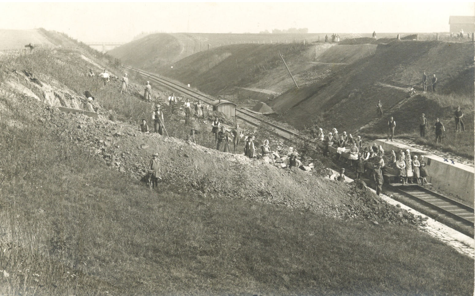
Veškeré práce na drážním tělese probíhaly ručně. Snímek zachycuje úpravy železničního zářezu mezi Hlučínem a Petřkovicemi. (Foto: archiv Muzea Hlučínska)
